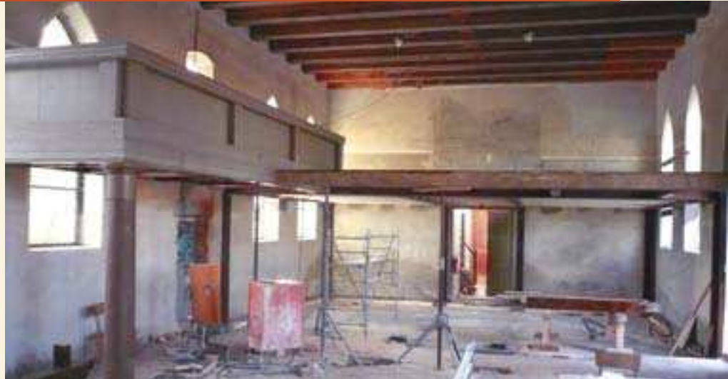
Innenraum der Dorfkirche Rieben während der Sanierung; Foto: Büro Götz & Ilsemann
